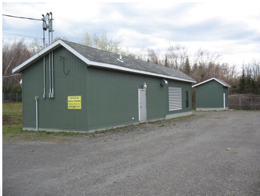
Vue du bâtiment de service principal et du bâtiment de service de Bélisle 2 en arrière-plan
